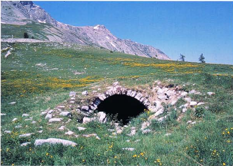
Fig. 3 - Col des Champs. La structure enterrée.
