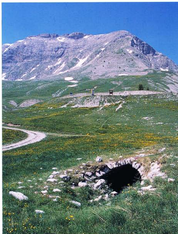
Fig. 2 - Col des Champs. La structure enterrée.
