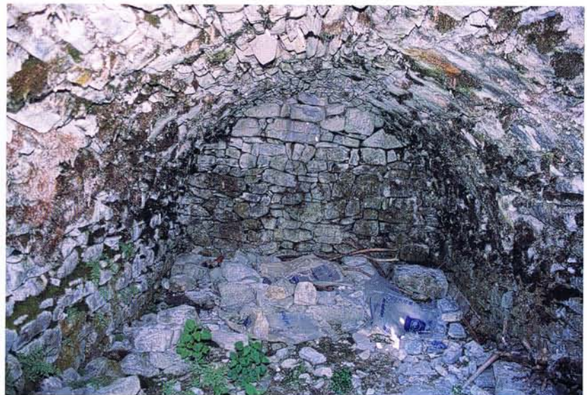
Fig. 8 - Col des Champs. Intérieur de la structure enterrée.
