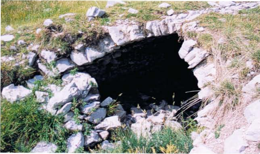
Fig. 5 - Col des Champs. Vue extérieure de la structure.
