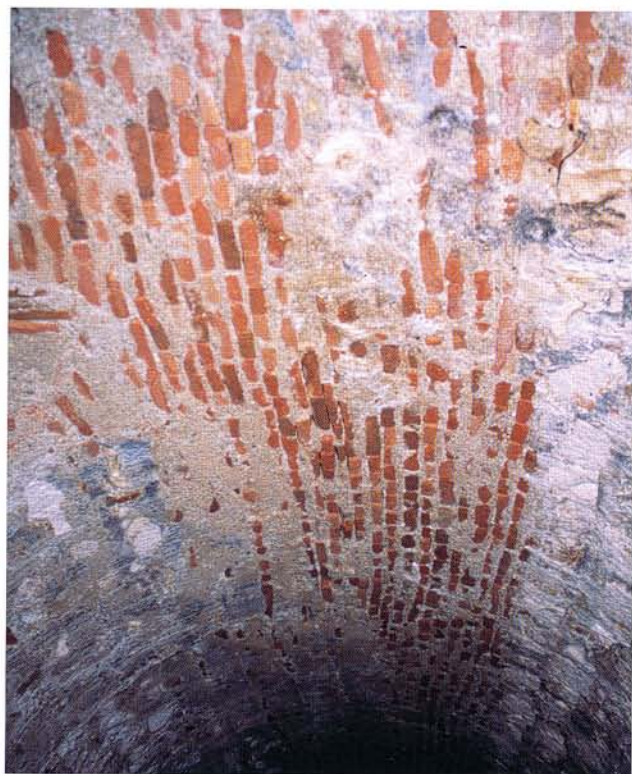
Fig. 3 - Nice. Canal des moulins. Voûte de la galerie des moulins, bâtie en tout venant et en briques rouges recouverts d'un enduit en partie décrépi.
