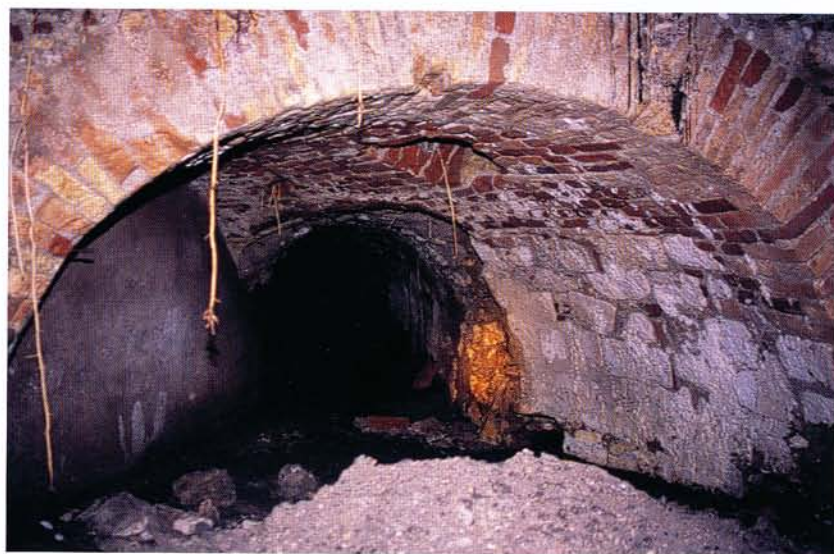
Fig. 5 - Nice. Canal des moulins. Entrée en entonnoir de la petite galerie. A gauche, obstruction de l'ancienne dérivation.
