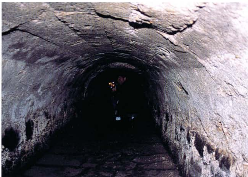
Fig. 6 - Nice. Canal des moulins. Côté aval de la petite galerie. On aperçoit le rétrécissement de la seconde section.
