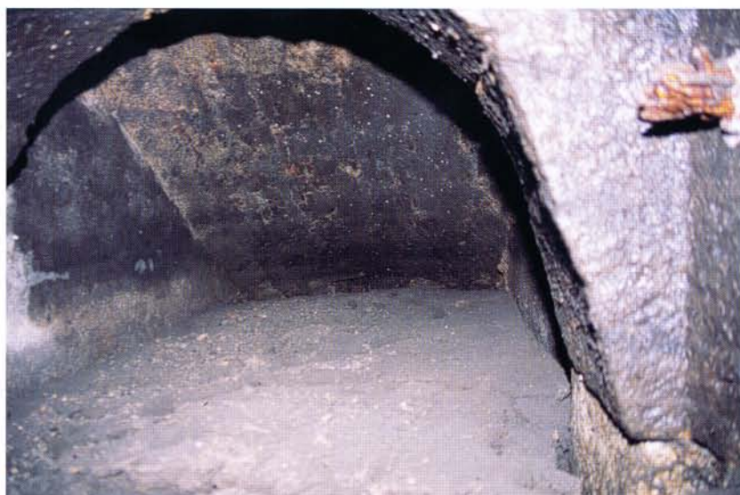
Fig. 8 - Nice. Canal des moulins. Chambre de décantation en cul-de-four, à l'extrémité sud (aval) de la petite galerie.
