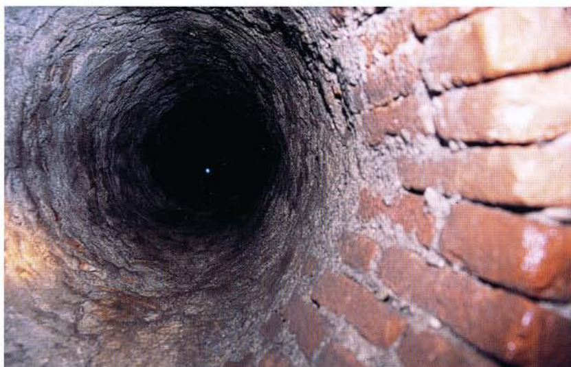
Fig. 7 - Nice. Canal des moulins. puits de jour de 5 m de hauteur, couvert par une plaque métallique au niveau de la chaussée de la rue Sulzer.
