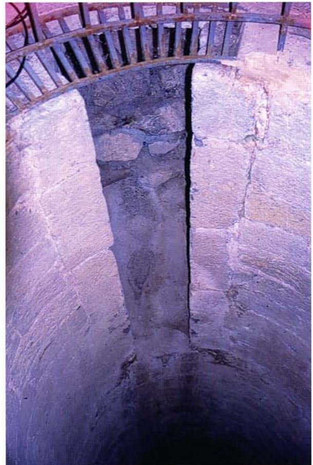
Fig. 5 - Puget-Rostang. Puits du moulin à farine.
