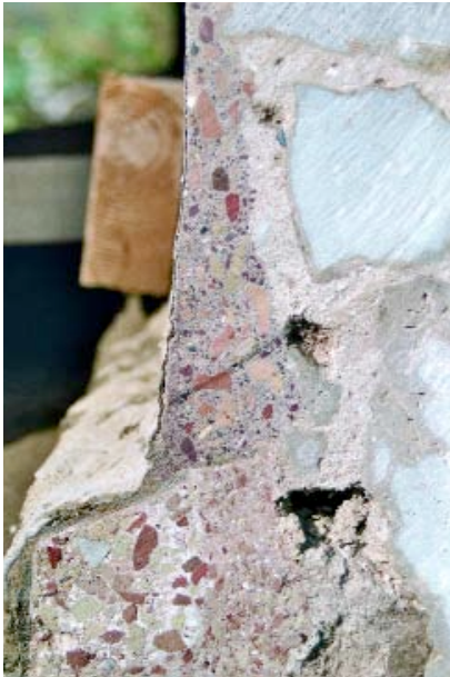
Fig. 11 - A l'enduit de mortier de tuileau antique en bas de la photo, se substitue en 1784, un enduit à base de pouzzolane de teinte lie de vin
