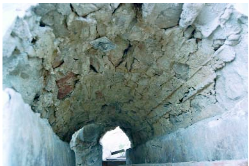
Fig. 10 - Empreintes des lattes en bois sur l'intrados témoignant des réfec-
