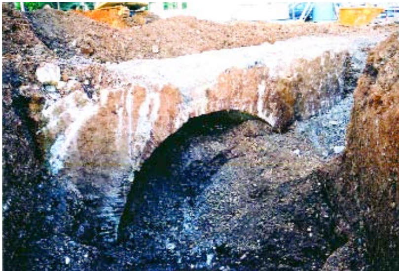
Fig. 14 - Le pont de l'aqueduc moderne vu de l'ouest (cliché Ph. Mellinand)
