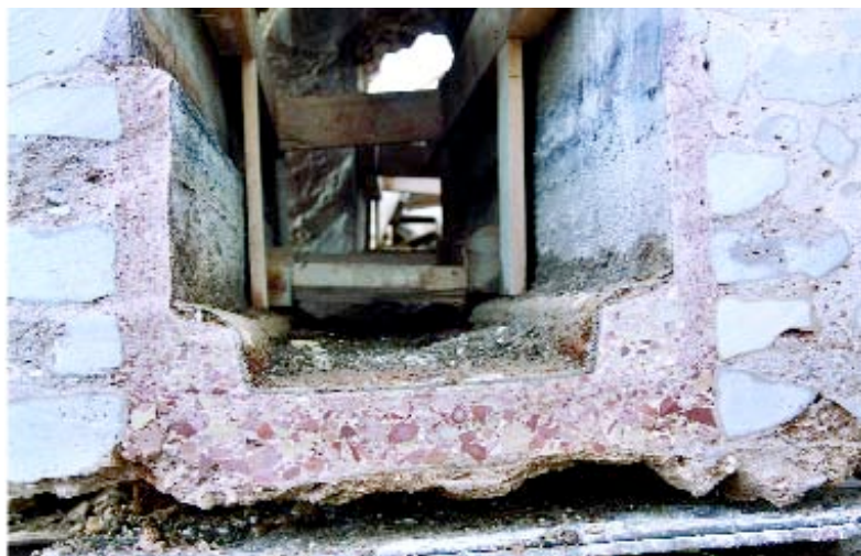
Fig. 8 - Sur cette vue du fond en mortier de tuileau de l'aqueduc antique, avec les enduits pariétaux plus fins et les solins d'étanchéité dans les angles, on distingue
