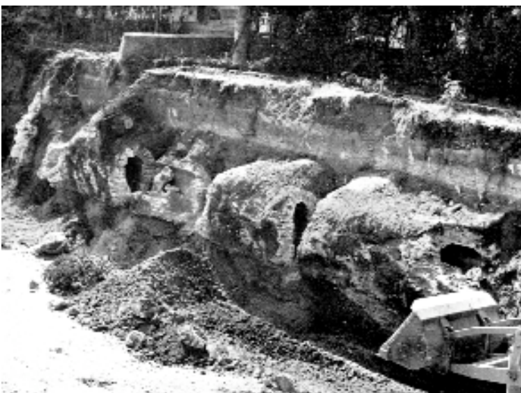
Fig. 4 - Vue de l'aqueduc détruit dans les années 1960 lors de la construction de l'immeuble Gansard (Clergues 1966 : fig 34)
