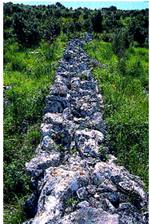
Fig. 13 - Redoute de Semboula. Mur d'enceinte.
