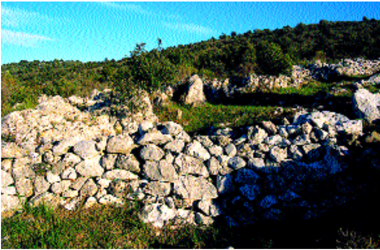
Fig. 15 - Redoute de Semboula. Secteur 1. Mur est et mur médian
