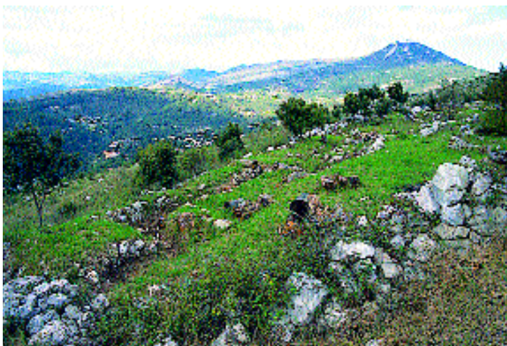
Fig. 14 - Redoute de Semboula. Tranchée inférieure en chicane.
