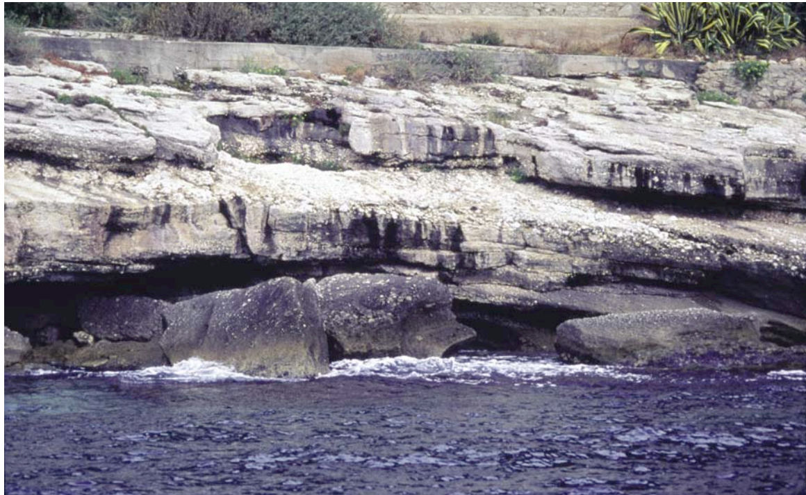
Fig. 7 - Erosion marine sous-jacente au banc des extractions et d'éboulement (photo DRASSM 18/8/95).
