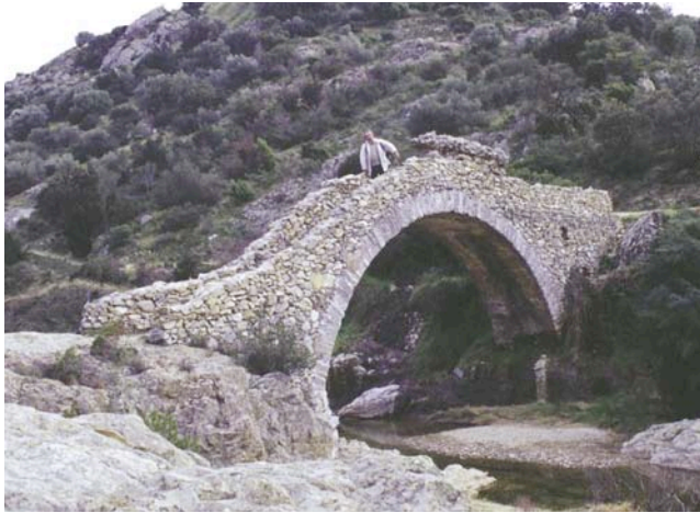
Fig. 5 - Grimaud. Pont-siphon des Fées.
