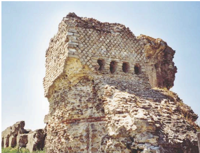
Fig. 14 - Siphon du Garon à Soucieu. Réservoir de chasse "La Gerbe". Diamètre des trous de branchement des tuyaux 25 cm. Largeur du rampant 7,35 m. En arrière plan, le canal d'aménée en partie ruiné.
