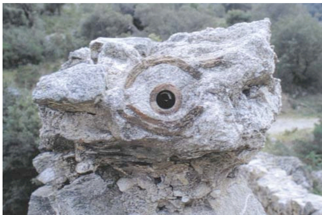
Fig. 6 - Conduit du pont-siphon des Fées à Grimaud.
