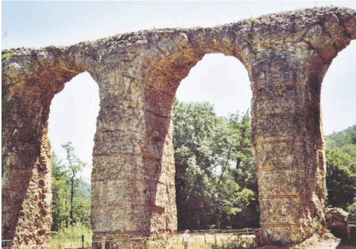
Fig. 21 - Pont-siphon du Garon. Largeur 7,35 m, hauteur maximale 21 m. Il portait dix tuyaux en plomb.
