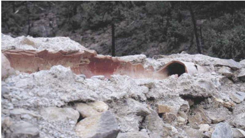
Fig. 3 - Conduit du pont-siphon de Breil-sur-Roya (photo H. Geist).
