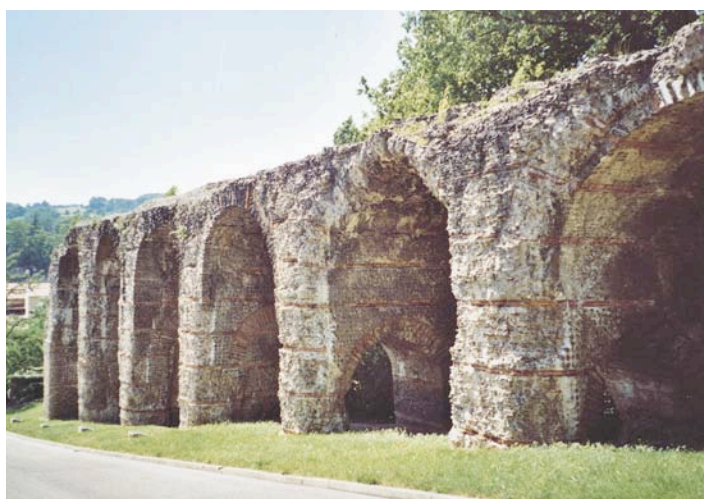
Fig. 16 - Pont-siphon de l'Yseron. Largeur 6 m, hauteur maximale 15 m. Il portait onze tuyaux en plomb.
