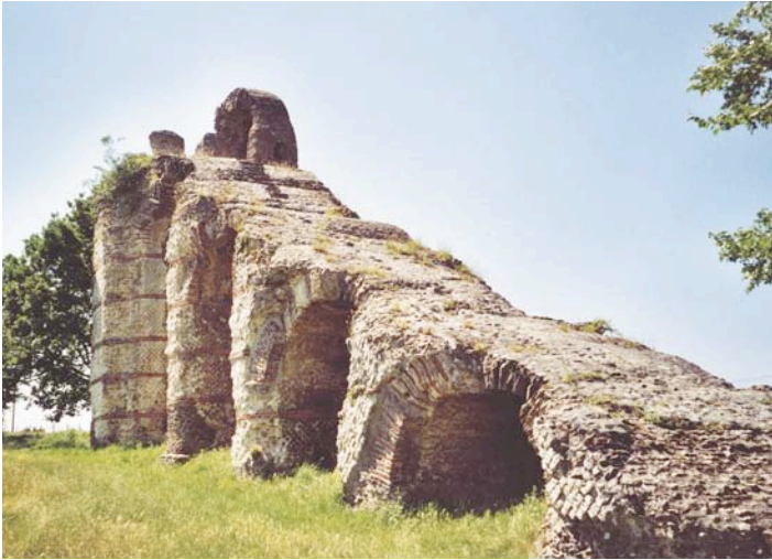
Fig. 13 - Siphon de l'Yseron à Beaunant. Réservoir de chasse et rampant sur quatre arches (largeur 6 m).
