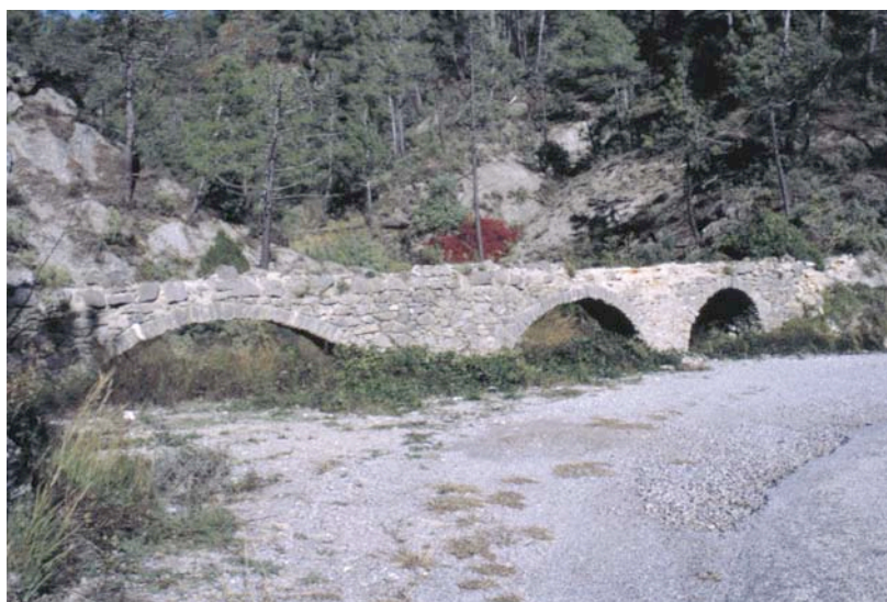
Fig. 2 - Pont-siphon de Breil-sur-Roya (photo H. Geist).
