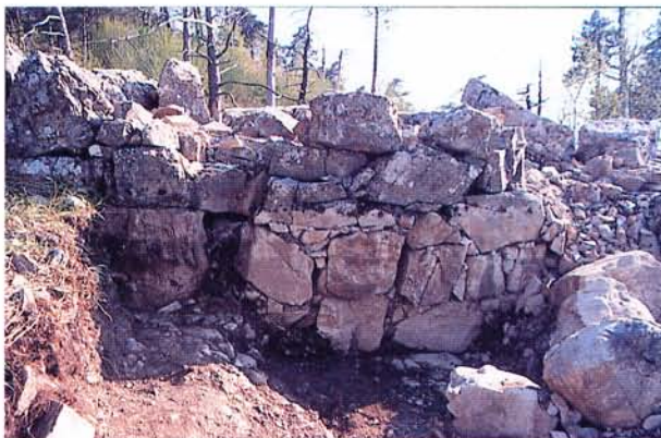
Fig. 2 - La Plastra. Sondage 1.
