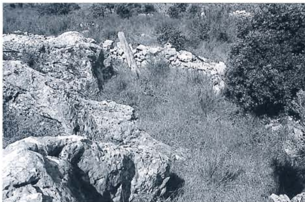
Fig. 2 - Détail du mur de la redoute de Semboula.
