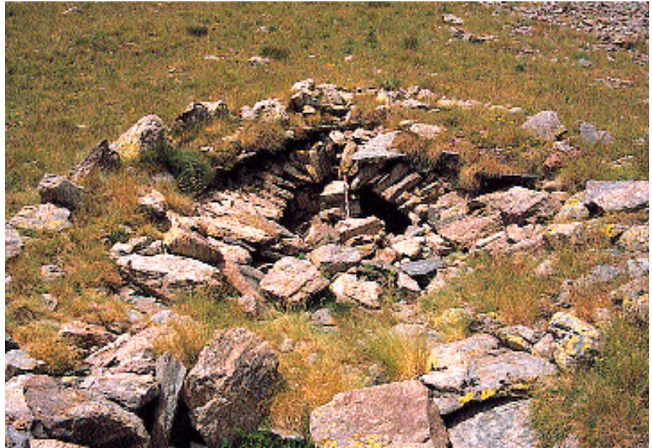
Fig. 1 - Valdeblore. Entrée et voûte de la structure pastorale enterrée.
