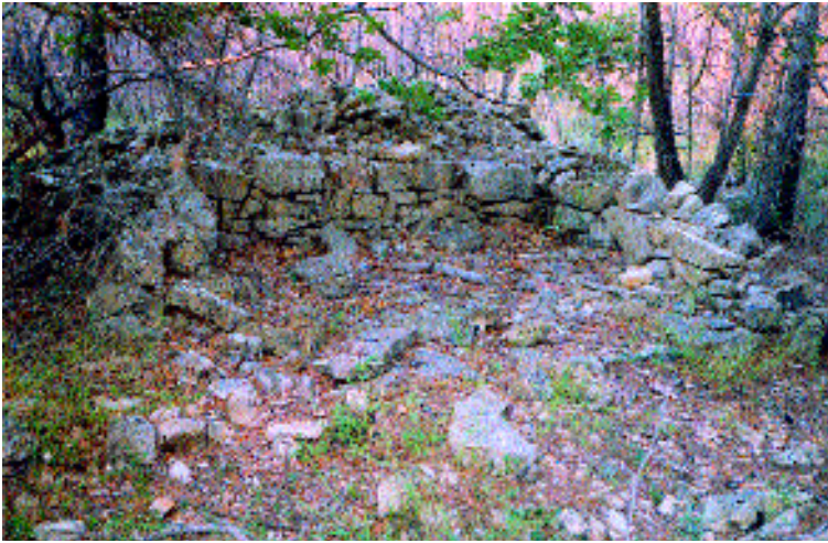
Fig. 13 - Entrecasteaux (83). Cargadou du vallon des Dalles.
