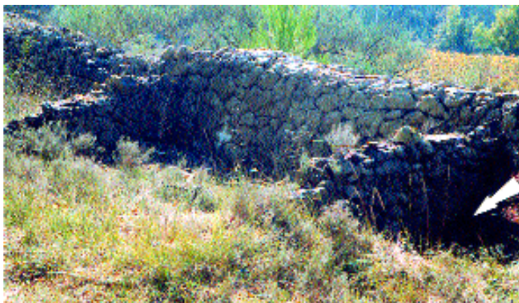
Fig. 10 - Entrecasteaux (83). Cargadou de Collet Redon. La flèche indique la position du conduit d'évacuation et le puisard.
