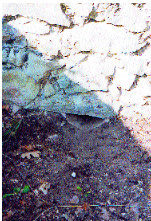
Fig. 11 - Entrecasteaux. Vue du canal d'évacuation à l'intérieur du cargadou de Collet Redon.
