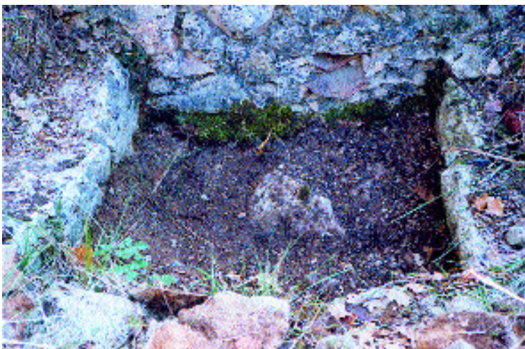
Fig. 12 - Entrecasteaux. Vue extérieure du canal d'évacuation et du puisard (?) du cargadou de Collet Redon.
